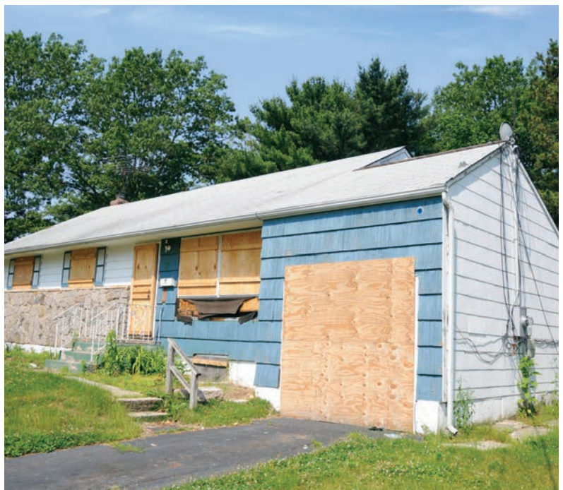
Esta casa en ejecución hipotecaria se ha dejado deteriorar, constituyendo un engendro para el barrio.
