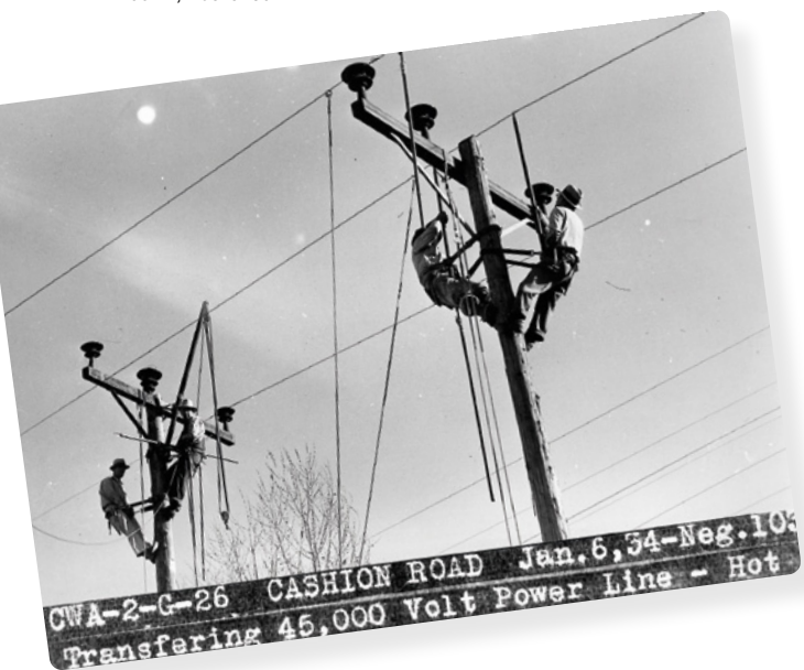
Construcción de líneas eléctricas en Cashion, un pueblo del condado de Maricopa en Arizona, en 1934. Crédito: Biblioteca Estatal de Arizona, Archivos y Registros Públicos, División de Archivos e Historia, Phoenix, #98-3250.
