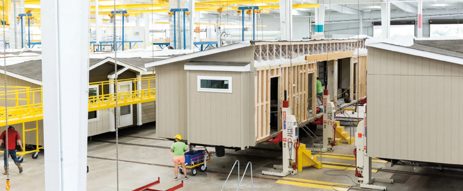
Viviendas prefabricadas en construcción en una fábrica en Athens, Alabama. Crédito: Clayton Homes.
