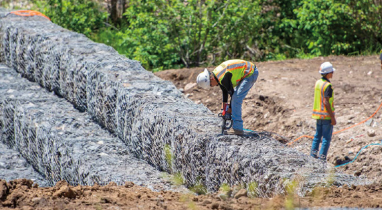
El control de las inundaciones en las áreas afectadas por el incendio del Hermits Peak y el Calf Canyon incluyó la instalación de represas temporales (izquierda) y barreras flotantes para reducir o detener los residuos grandes (derecha). Créditos (de izquierda a derecha): Cuerpo de Ingenieros del Ejército de los Estados Unidos, Servicio Forestal de los Estados Unidos.
