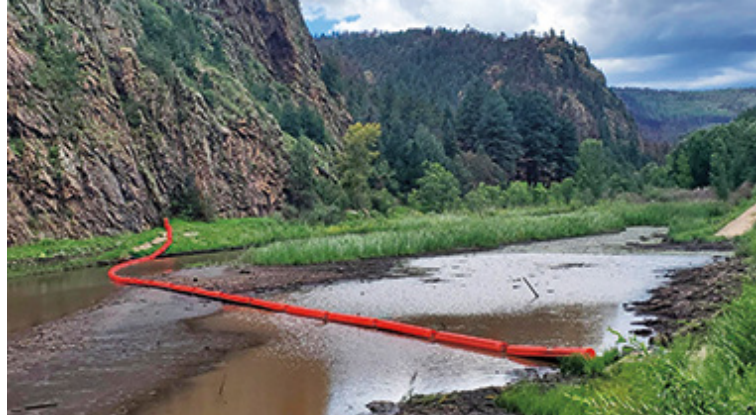
El control de las inundaciones en las áreas afectadas por el incendio del Hermits Peak y el Calf Canyon incluyó la instalación de represas temporales (izquierda) y barreras flotantes para reducir o detener los residuos grandes (derecha). Créditos (de izquierda a derecha): Cuerpo de Ingenieros del Ejército de los Estados Unidos, Servicio Forestal de los Estados Unidos.
