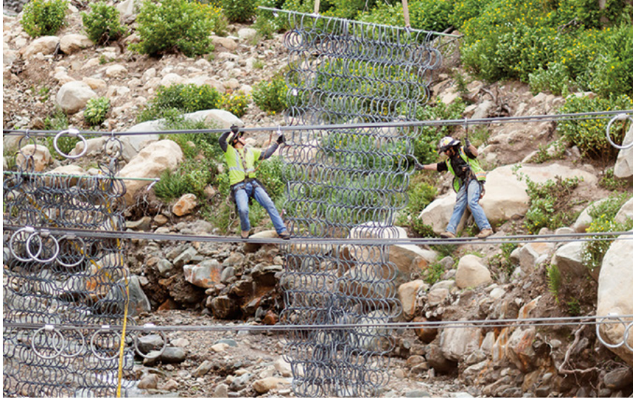
En 2019, trabajadores instalaron un tejido de acero en San Ysidro Canyon arriba de Montecito, California, para reducir el impacto de los flujos de residuos posteriores a los incendios forestales. Dos años antes, las avalanchas de lodo se cobraron la vida de 23 residentes de la comunidad y destruyeron 130 hogares. Crédito: Christy Gutzeit.
