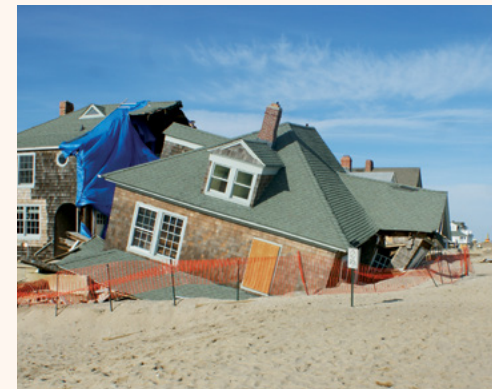
El huracán Sandy destruyó muchos hogares a lo largo de la costa de Nueva Jersey al tocar tierra el 29 de octubre de 2012. Fuente: L. Johnson (2013).
