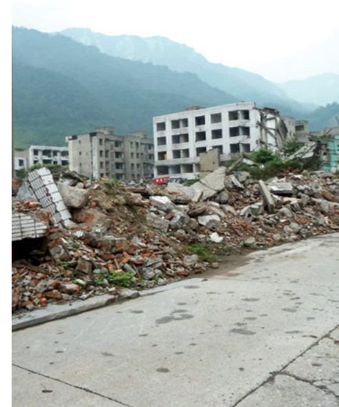
El terremoto de 2008 en la provincia de Sichuan, China, causó daños graves a muchas ciudades de toda la región, entre ellas gran parte de la ciudad industrial de Hanwang, Mianzhu. Crédito: R. Olshansky (2011)
