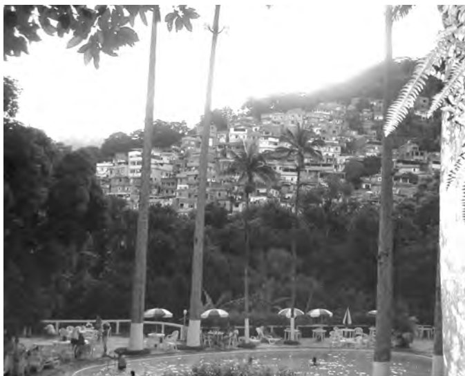
Vivienda informal construida en zonas con riesgo ambiental sobre laderas de cerros a un costado de un club privado en Rio de Janeiro.
