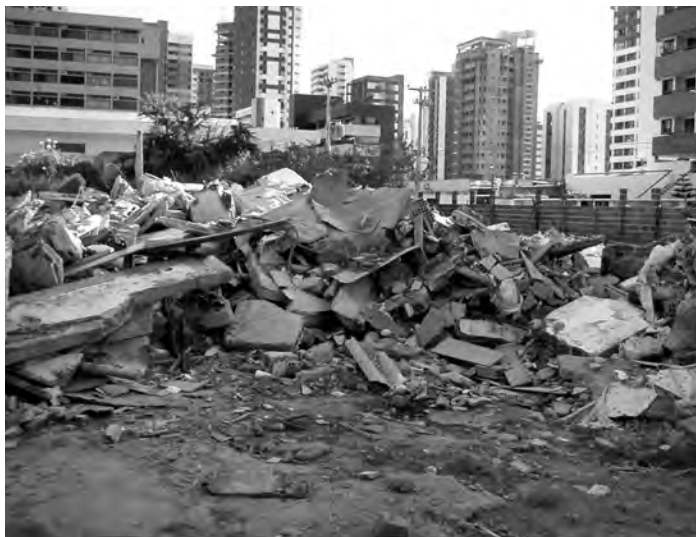
Demolición de favelas para dar paso a un nuevo desarrollo inmobiliario en un importante centro urbano de Brasil.
