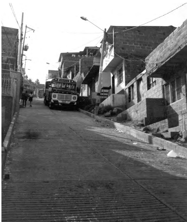
Barrio de Medellín donde PRIMED está involucrado en la intervención y consolidación de obras de infraestructura.
