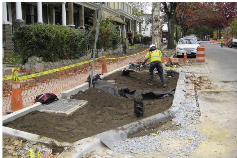
Instalación de un ensanche para biorretención en Washington, DC, donde un programa de Bonos Verdes ofrece capital para proyectos de gestión de agua pluvial y cloacas. Crédito: Chesapeake Stormwater Network.
