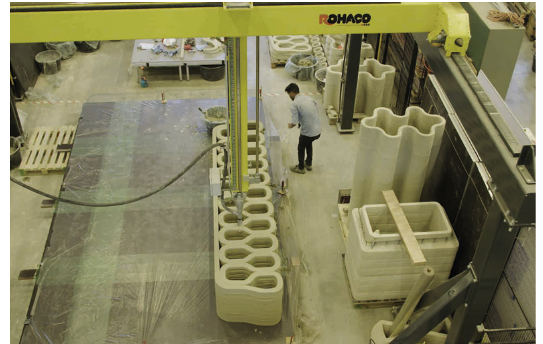
La construcción de las viviendas impresas será similar al proceso de impresión del puente, que se muestra aquí: varios elementos se construyen en el laboratorio de la universidad y luego se transportan y ensamblan en el sitio previsto para el desarrollo. Crédito: Imagecollectors.
