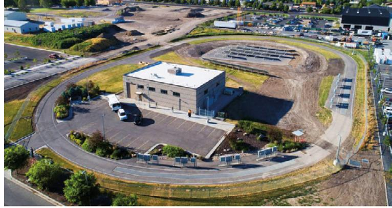
Pista de prueba del Centro de Investigación en Ingeniería ASPIRE en North Logan, Utah, emplazamiento de un proyecto de demostración de electrificación de una ruta que usa tecnología de carga inalámbrica provista por Electreon. Crédito: cortesía de ASPIRE.
